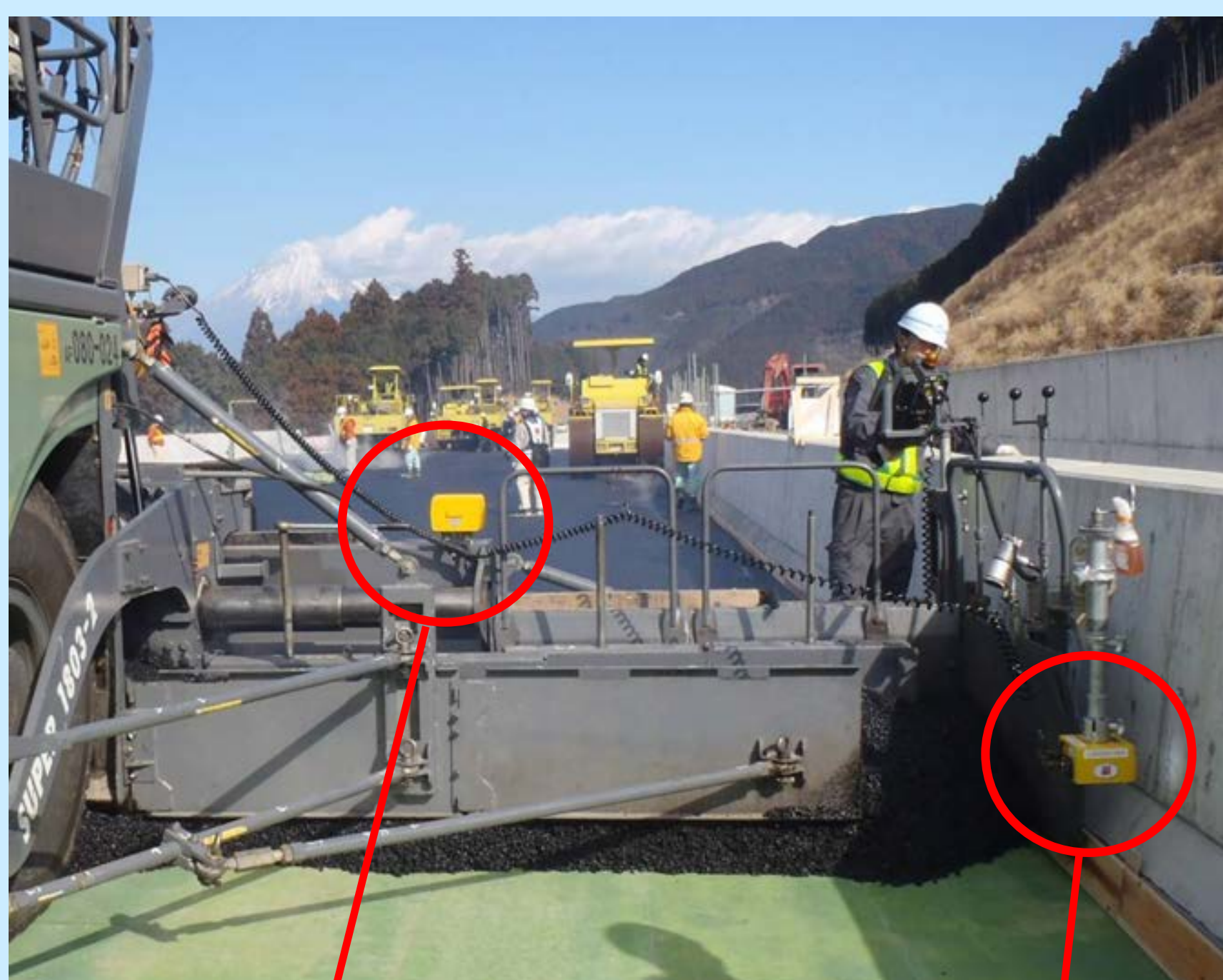
現場施工状況
