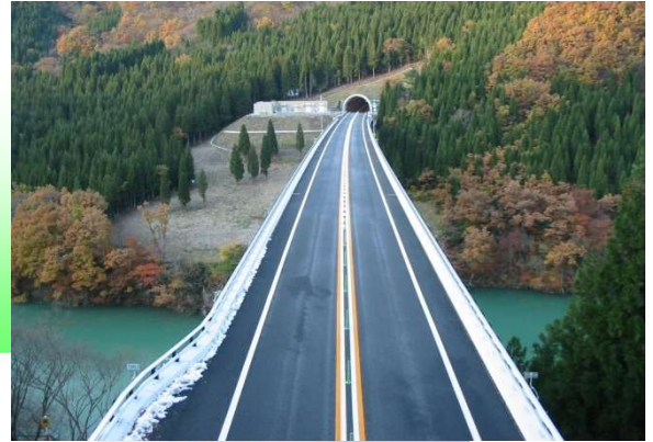
東海北陸自動車道(岐阜県)
