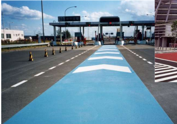
道央自動車道ETCレーン(北海道)
