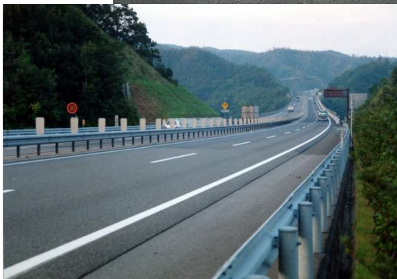
山陽自動車道(広島県)
