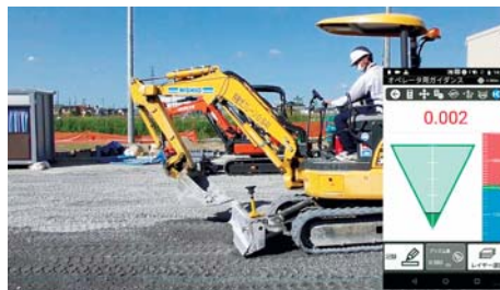
ガイダンス(画像右側)に従い施工
