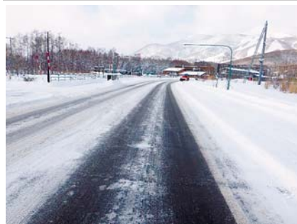
ツインメルトペープE施工個所の冬季供用状況
