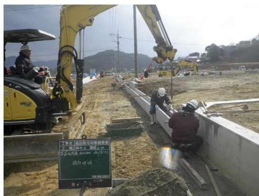
高田南宅地整備事業 落蓋式側溝 (300*300*2000)
