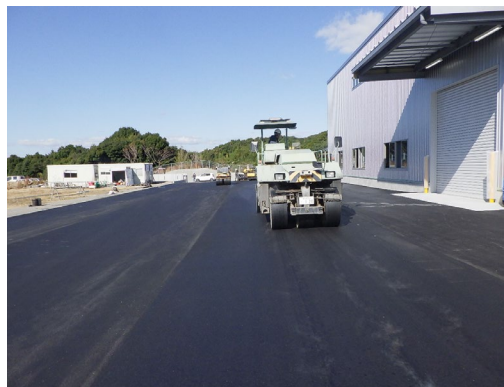
南諫早製缶工場新築工事 西側アスファルト舗装 S=1766m 2 , 排水工L=230m, 縁石L=115m, フェンスL=88m 再生密粒度アスコン(13) : t=50
