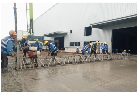
ブリッツスクリード均し機によるスラブコンクリート工事 人件費が安価なため人力施工が多いですが、品質は良好です。 【ドンナイ省】
