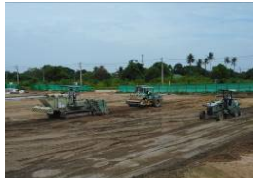
スタビライザを用いたセメント地盤改良工事 軟弱地盤の多いタイでは非常に有効な工法 【チョンブリ県 工場外構工事現場】
