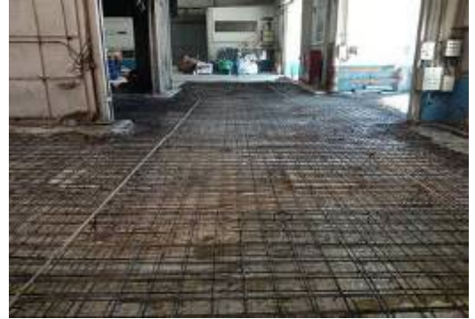
既存工場のスラブ補修工事 沈下によりスラブが破壊し、コンクリートの再打設 【チョンブリ県 ゲートウェイ工業団地内】
