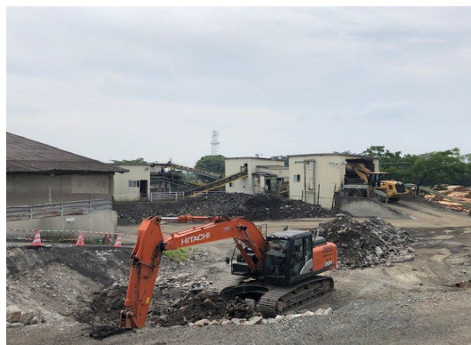
中間処理工場
