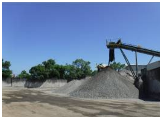
再生製品ストックヤード
