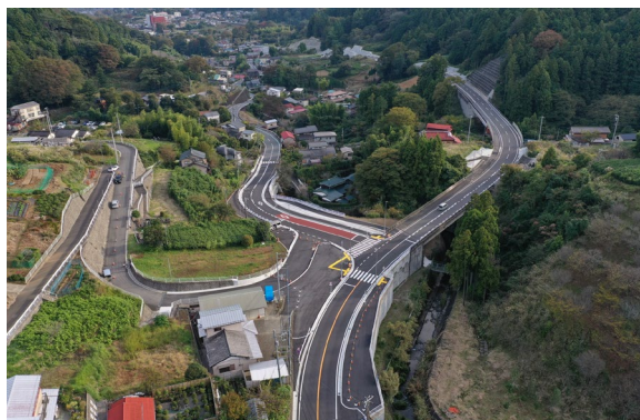
県道64号道路改良工事（清川村）
