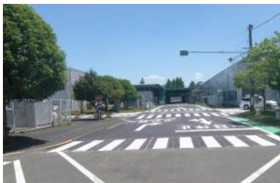
日立製作所厚木工場構内道路工事（厚木市）
