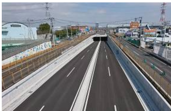
国道129号戸田立体交差工事（厚木市）
